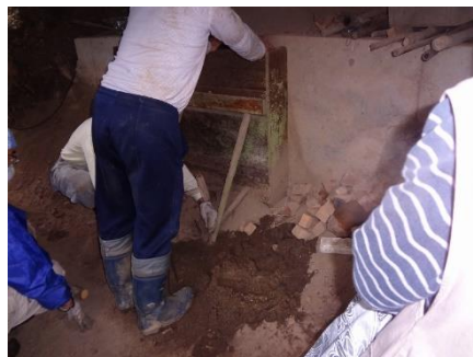
窯口封鎖作業
