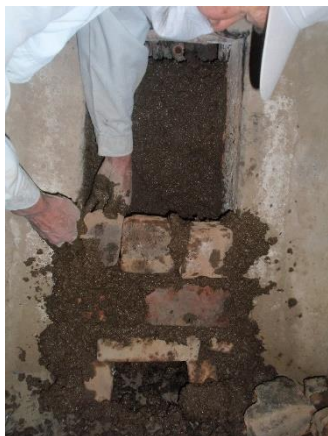
窯口封鎖作業
