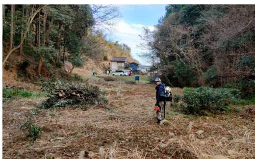
景観整備を実施した作業後の状況
